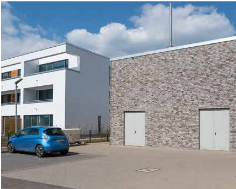
Ein Biogas-BHKW mit einer Leistung von 900 Kilowatt versorgt das Neubaugebiet in Keldenich mit Wärme.
