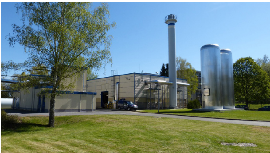
BHKW und Heizwerk mit Wärmespeicher im Zwickauer Stadtteil Neuplanitz
